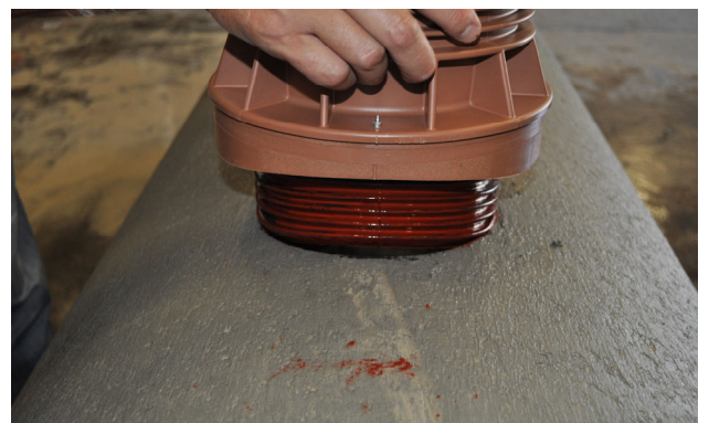
Bild 11: Steckanschlussstück ansetzen, Markierung beachten
