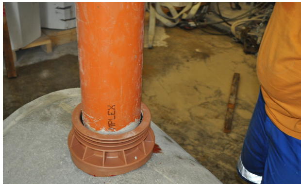
Bild 14: Anschlussrohr anschliessen
