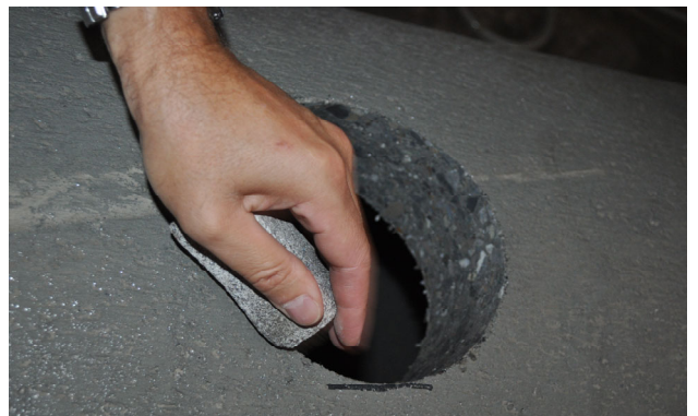
Bild 7: Bohrlochkante abrunden und Bohrloch reinigen
