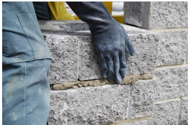
Bild 59: Versetzen von Pfeilerspaltsteinen
