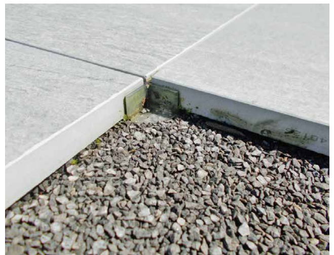
Bild 7: Verlegen der Feinsteinzeug Gehwegplatten in Bettungsschicht
