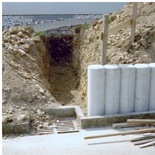
Bild 8: Aushub für Streifenfundament
