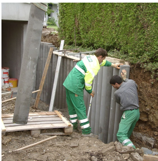
Bild 12: Versetzen und Richten von Palisaden
