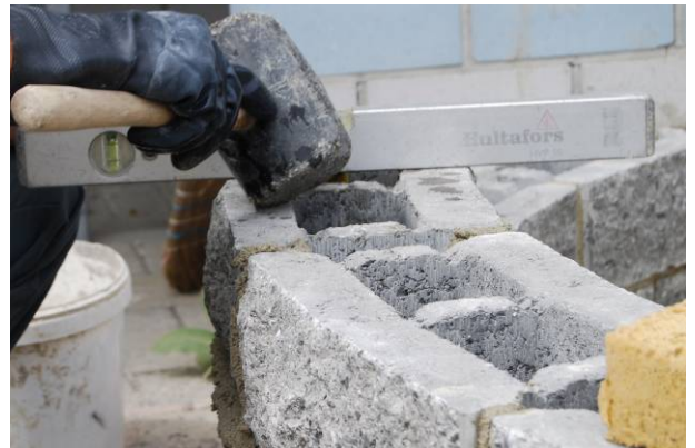
Bild 44: Richten und anklopfen des versetzten Spaltsteines
