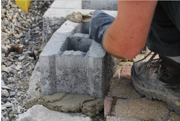
Bild 36: Versetzen der ersten Steinlagen, von einem Ende her beginnend
