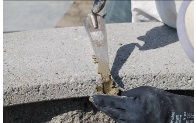
Bild 64: Verfugen der Abdeckplatten
