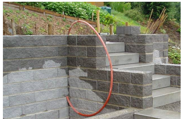
Bild 40: Einlegen der Leerrohre
