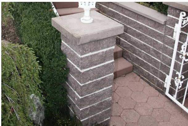
Bild 4: Versetzte Pfeilerspaltsteine
