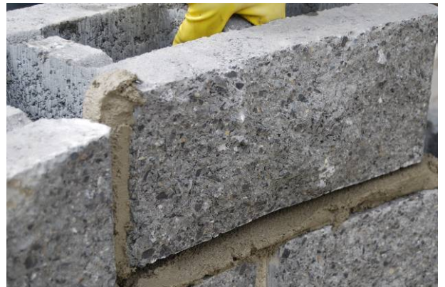
Bild 43: Versetzen des Mauersteines auf die Mörtelschicht
