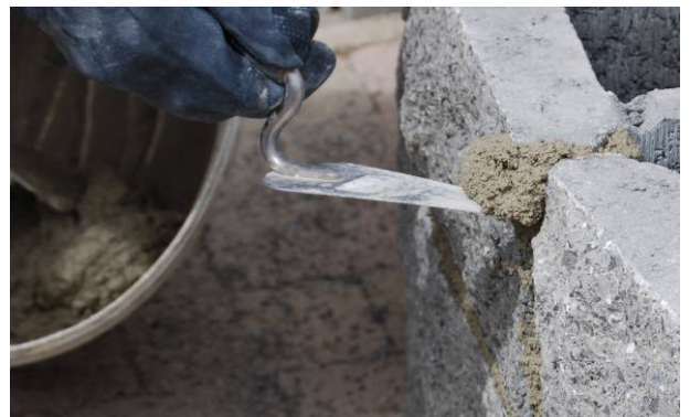
Bild 45: Entfernen von überschüssigem Mörtel
