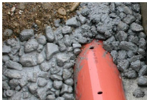
Bild 33: Eingebaute Sickerleitung
