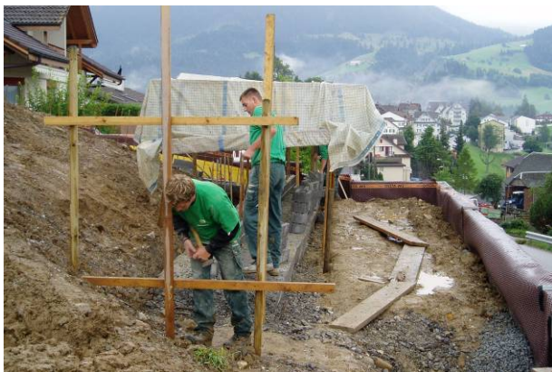
Bild 34: Setzen einer Richtschnur
