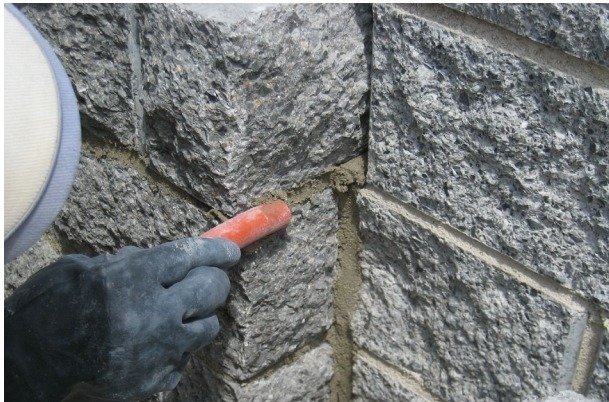
Bild 47: Modellieren der Fuge mit einem Kunststoffrohr
