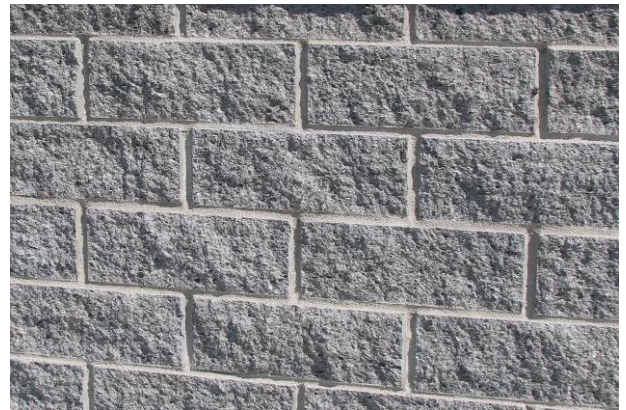
Bild 5: Oberfläche der Spaltsteine, grau mit Splittkorn
