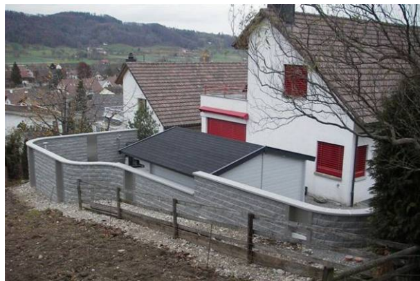
Bild 2: Doppelspaltsteine, eingesetzt als freistehende Mauer
