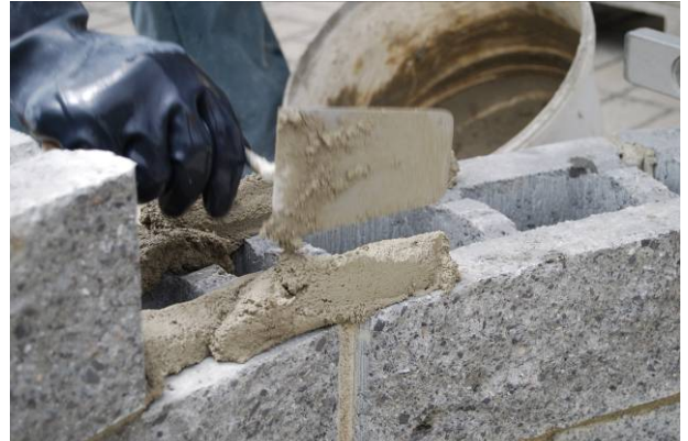
Bild 42: Aufbringen der Mörtelschicht
