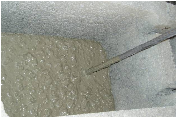
Bild 51: Füllhöhe bei der obersten Lage pro Betonieretappe
