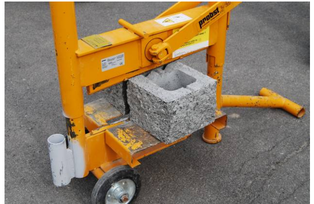
Bild 54: Trennen der Spaltsteine mit Steinspalter
