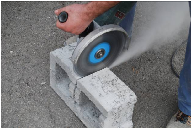
Bild 52: Trennen der Spaltsteine mit Winkelschleifer
