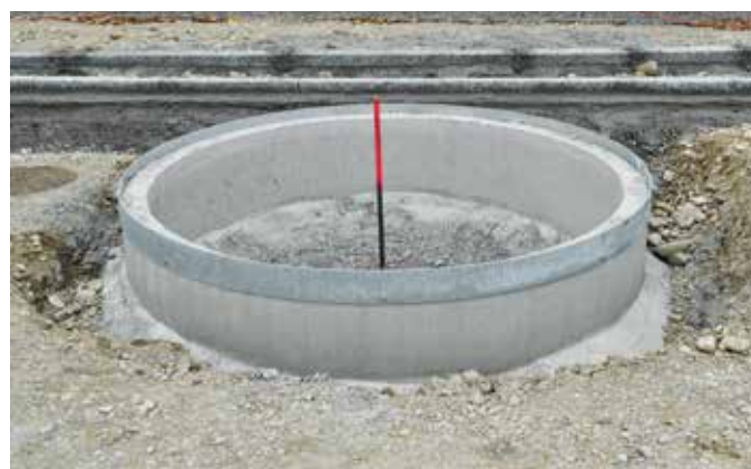
Montierter Stahlleinbaurahmen mit Bolzenanker
