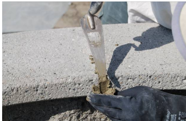
Bild 64: Verfugen der Abdeckplatten
