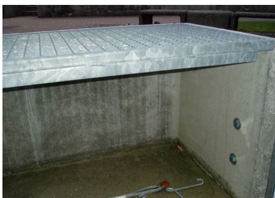
Bild 39: Verstärkte Gitterrostkante gegen die Hauswand
