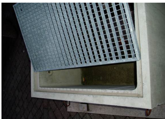
Bild 38: Gitterrost auf Falz (S. Position 13)
