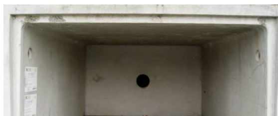
Bild 28: Lichtschachtsohle mit eingebautem Boden
