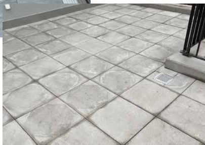
Kalkausblühung in Form weisser Kristallablagerung
