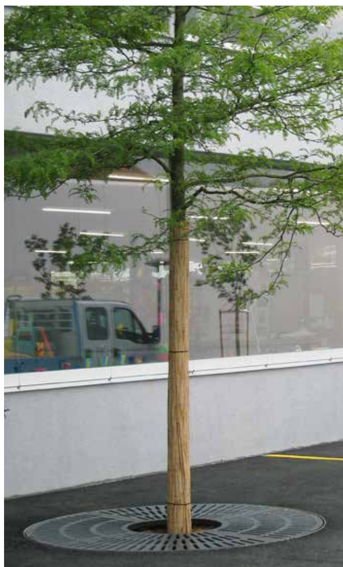
TREETUB Baumwurzelraumschutz mit Gussrost
