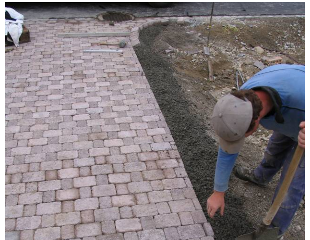
Bild 43: Erstellen des Randabschlusses
