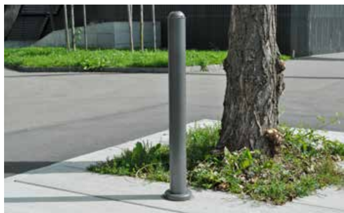
Stammschutzpfahl für sämtliche Betonabdeckungen
