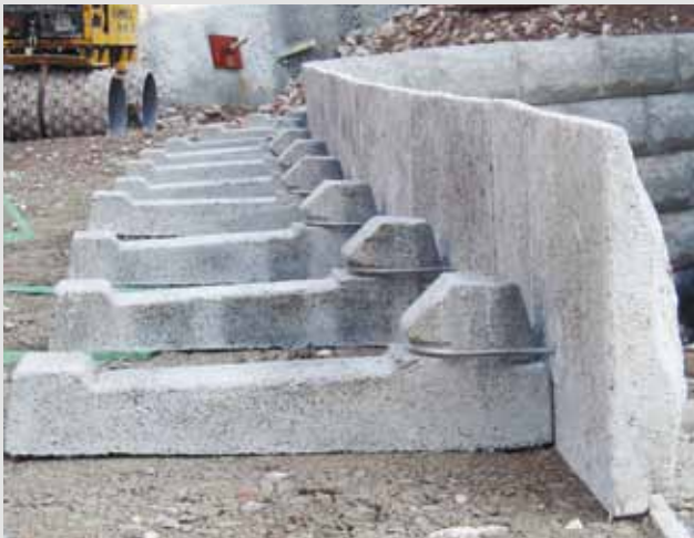
Frontplatten mit Erdanker
