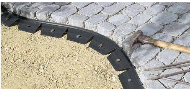
Randabschluss mit PAVE EDGE® Randschienen
