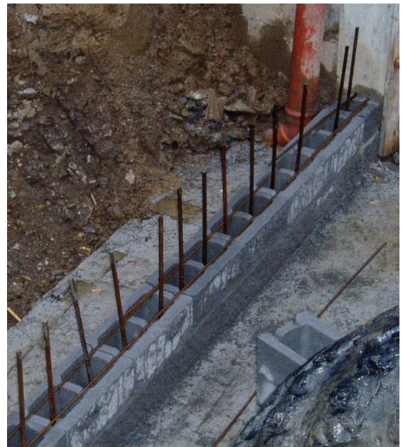
Bild 11: Horizontale und vertikale Bewehrung (Produktneutral)
