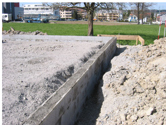
Bild 2: SCHALIT Schalungsstein als Frostriegel
