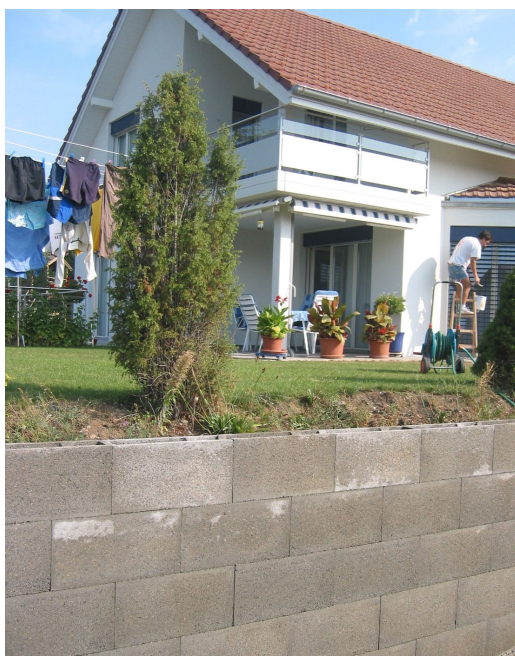
Bild 1: SCHALIT Schalungsstein als Hangsicherung
