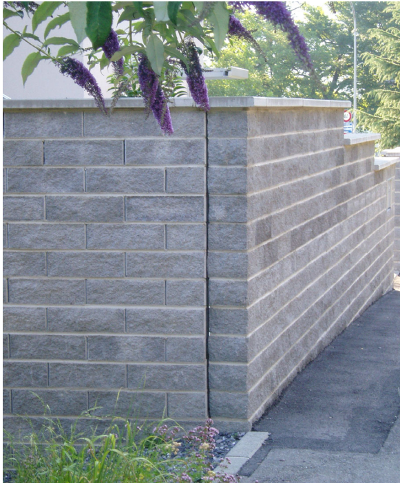
Bild 15: Dilatationsfuge (Produktneutral)
