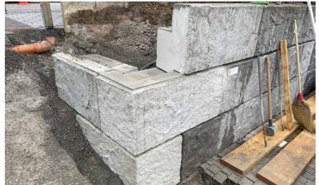
Bild 24 Versetzen der Eckelemente
