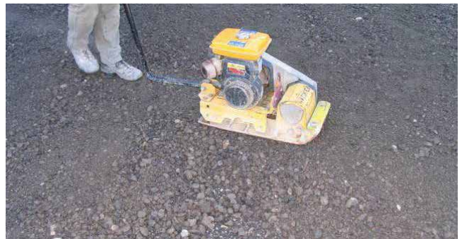
Verdichten der Fundationsschicht
