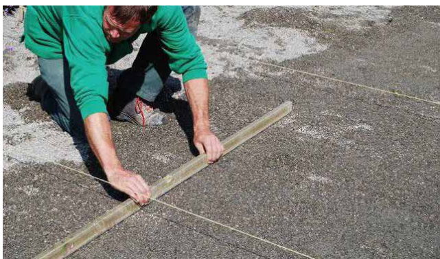
Abziehen der Bettungsschicht
