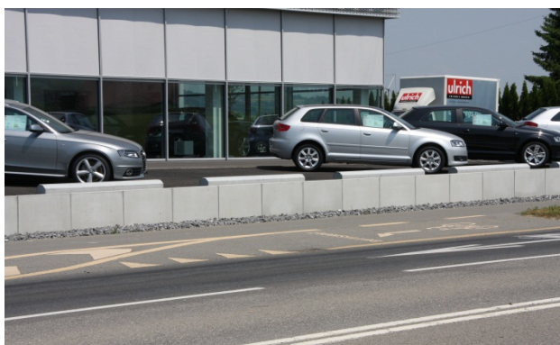
Bild 1: Winkelplatten als Böschungssicherung
