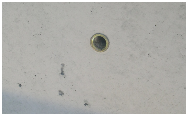
Bild 20: Werkseitig eingebaute Versetzhülse
