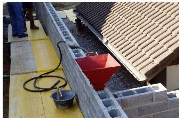
Bild 50: Einbringen von Füllbeton mit einem geeigneten Trichter
