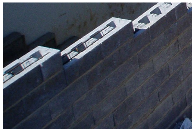
Bild 49: Bewehrungseinlagen, eingelegt in die vorgesehene Nuten
