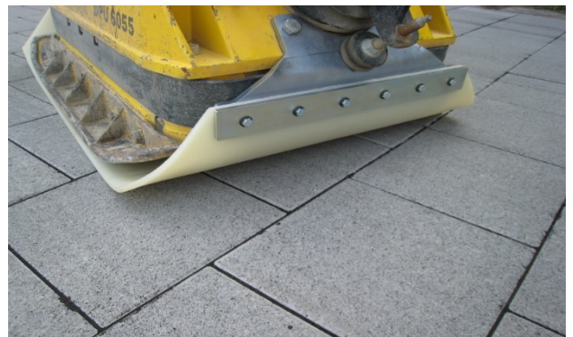
Bild 29: Abrütteln der Pflasterdecke
