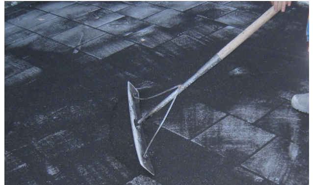
Bild 28: Einbringen des Fugenmaterials von Hand
