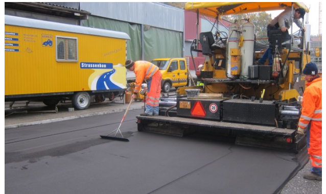
Bild 2: Einbau von ECOPREC®-Bettungsmaterial
