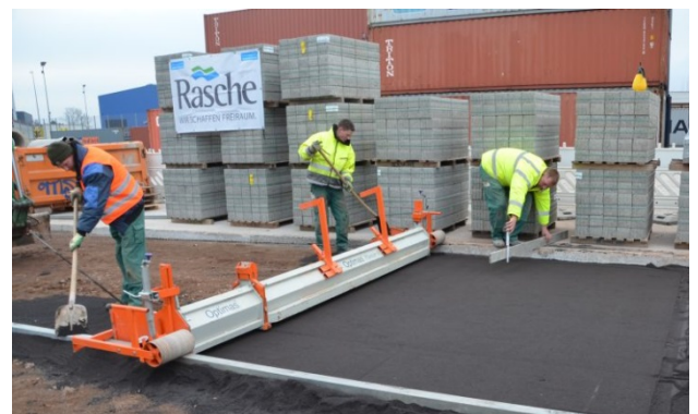
Bild 19: Mischgut abziehen
