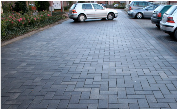
Bild 1: Pflasterdecke mit ECOPREC®-Bettungs- und Fugenmaterial
