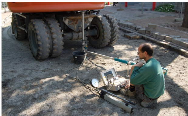
Bild 13: Kontrolle der Tragfähigkeit mit Me-Messungen
