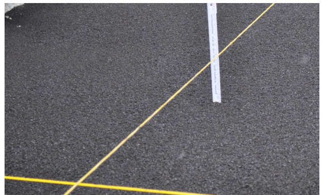
Bild 22: Kontrolle der Einbauhöhe
