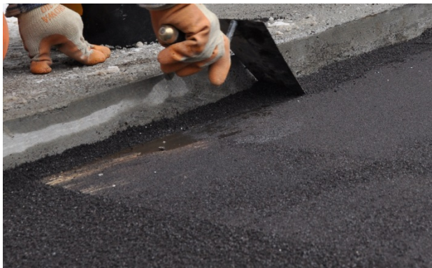
Bild 24: Kontrolle der Ränder
