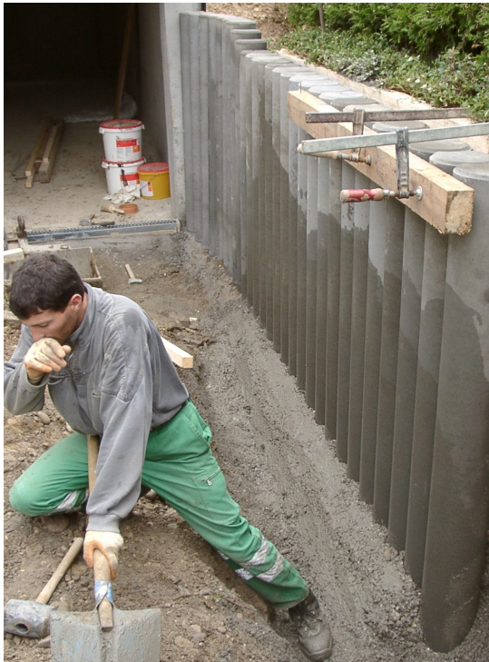
Bild 15: Einbetonieren der Palisaden
