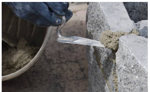
Bild 45: Entfernen von überschüssigem Mörtel
