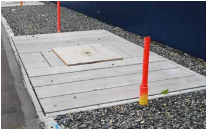
Einbau von Bewässerungs- und Belüftungsleitungen
