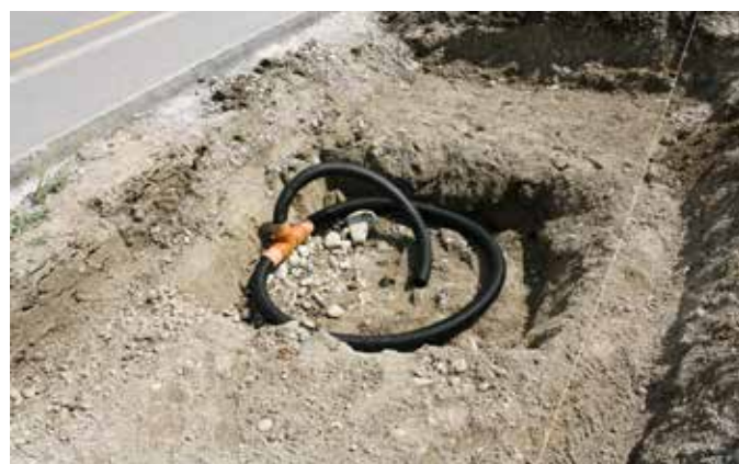
Vorbereitete Sickerrohre in der Baumgrube
