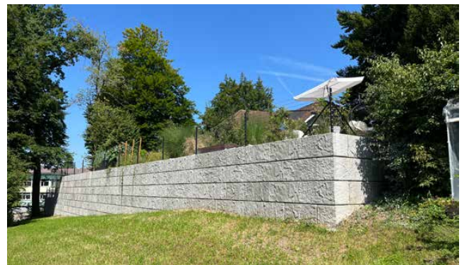
Bild 26 Geländer auf Mauerkrone
