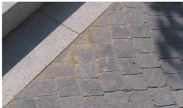
Pflasterfläche mit Passsteinen
