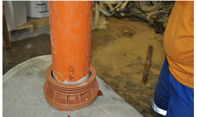
Bild 14: Anschlussrohr anschliessen
