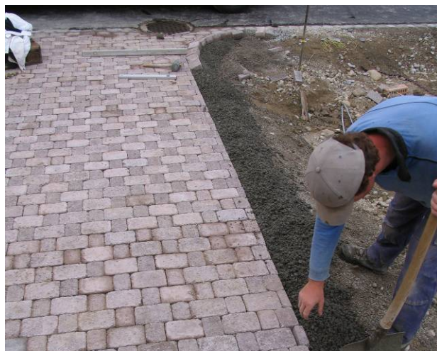
Bild 43: Erstellen des Randabschlusses
