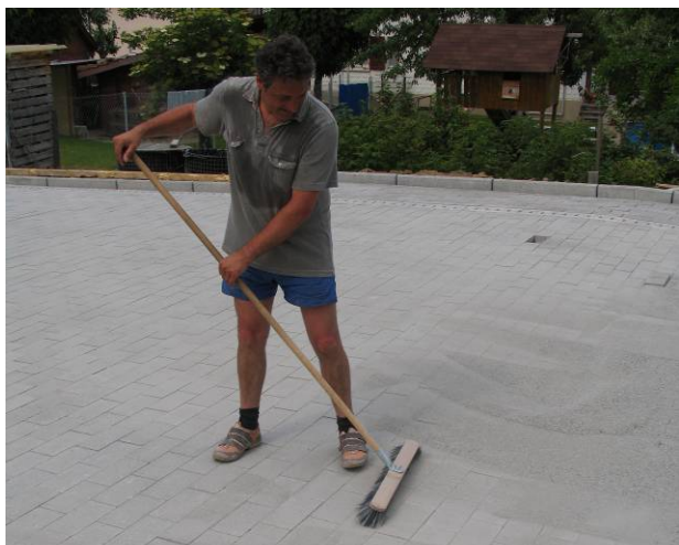
Bild 37: Einsanden der Fugen
