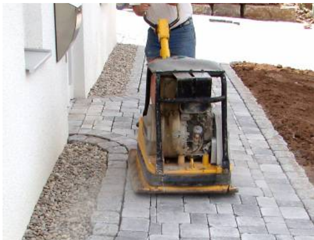
Bild 36: Abrütteln der Pflasterfläche
