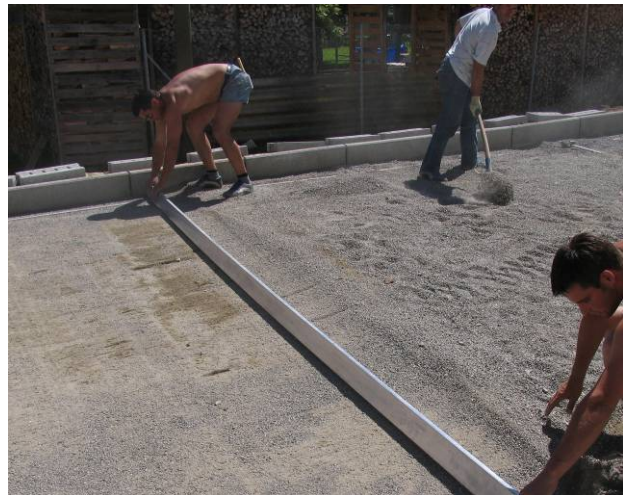
Bild 33: Abziehen der Bettungsschicht
