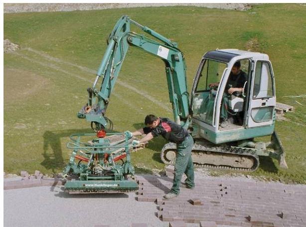
Bild 38: Verlegemaschine im Einsatz
