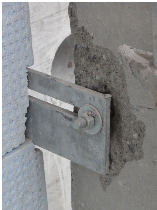
Bild 30: Abplatzungen am Lichtschacht durch unvorsichtiges bohren der Löcher für die Befestigungswinkel
