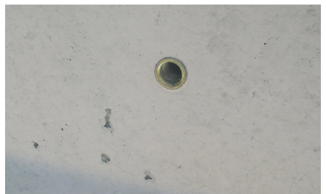
Bild 20: Werkseitig eingebaute Versetzhülse
