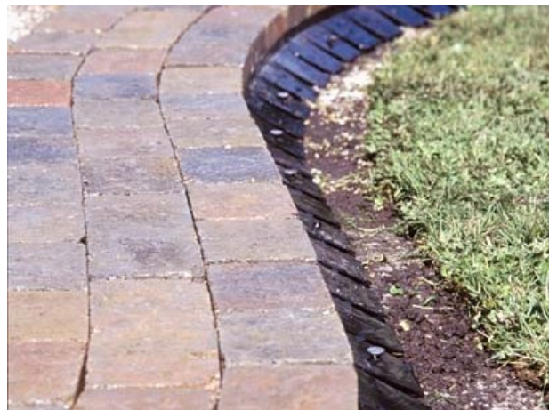
Bild 44: Randabschluss mit PAVE EDGE Randschienen
