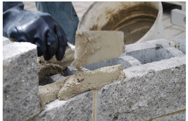
Bild 42: Aufbringen der Mörtelschicht
