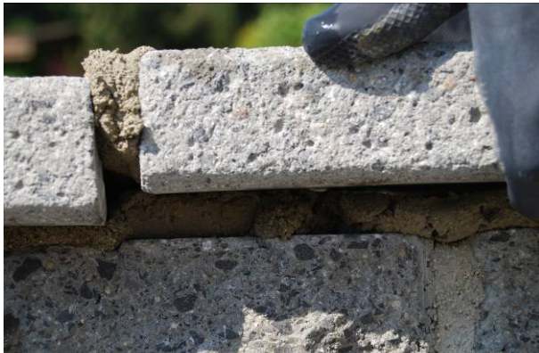
Bild 63: Versetzen der Abdeckplatten
