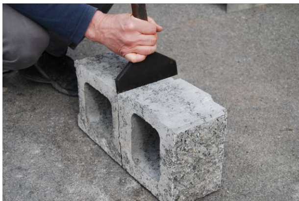
Bild 53: Trennen der Spaltsteine mit Meissel
