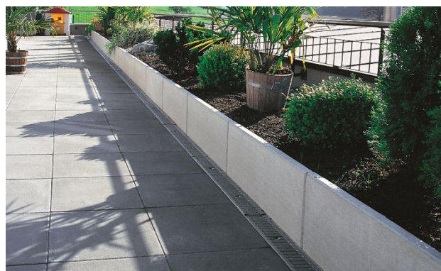
Bild 30: Mögliche Bepflanzungen im Bereich von Winkelplatten
