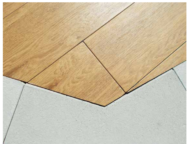
Bild 8: Passstück Feinsteinzeug Gehwegplatte
