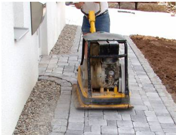
Bild 36: Abrütteln der Pflasterfläche
