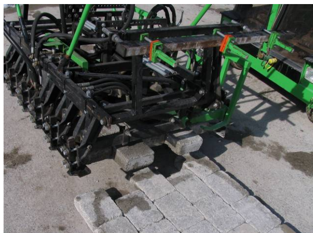
Bild 39: Maschinelle Verlegung mit OPTIMAS Verlegemaschine
