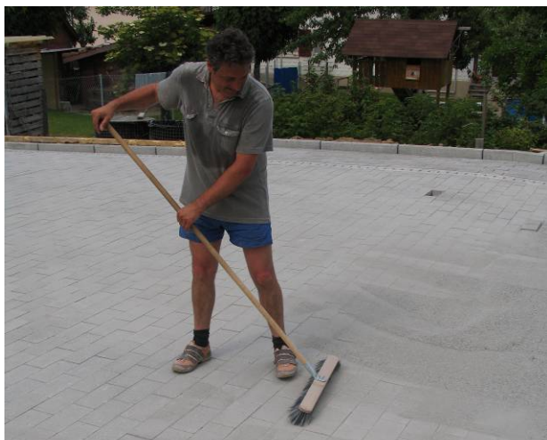
Bild 37: Einsanden der Fugen
