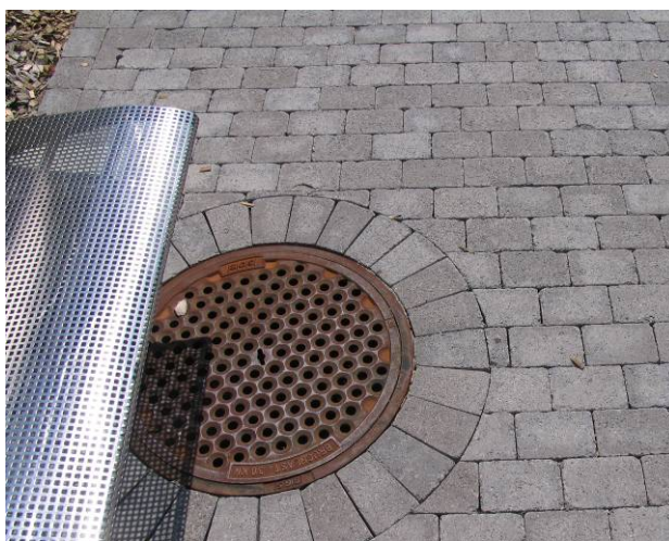
Bild 42: Anpassung bei Schachtabdeckung
