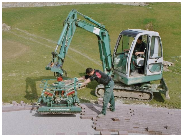
Bild 38: Verlegemaschine im Einsatz
