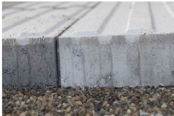
Bild 37: Verlegte CARENA® Sicherheitsliniensteine H = 6 cm
