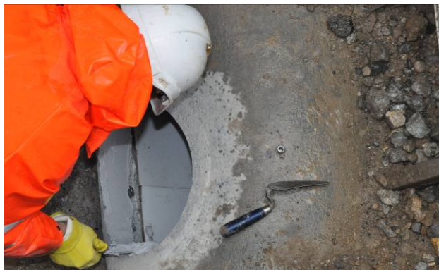
Bild 10: Klebmasse auf die Bohrlochwandung auftragen
