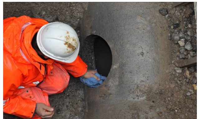
Bild 7: Bohrloch reinigen
