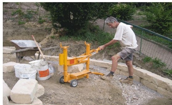
Bild 35: Arbeiten mit Steinspalter
