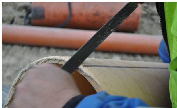
Bild 14: Anfasen des Kunststoffrohres, reinigen und einschmieren
