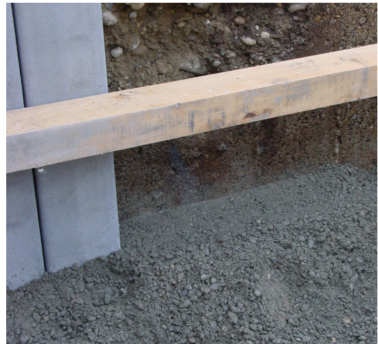
Bild 7: Vorbereitete Sohle mit Richtlatte
