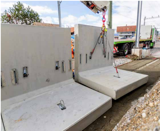
Werkseitig eingebaute Seilschlaufen
