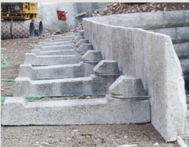
Frontplatten mit Erdanker
