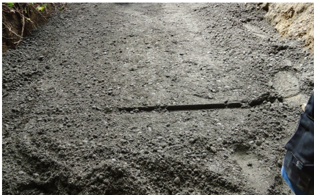
Bild 23: Erstellen des Streifenfundamentes
