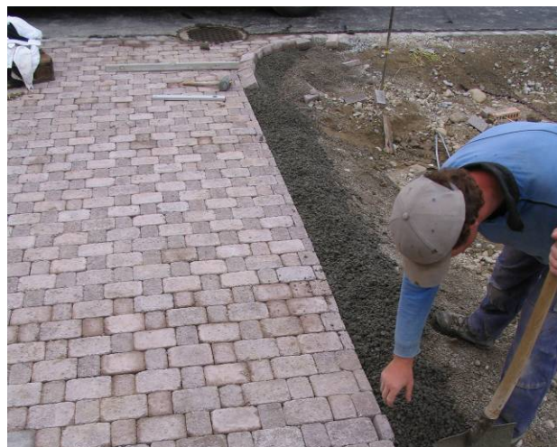
Bild 43: Erstellen des Randabschlusses
