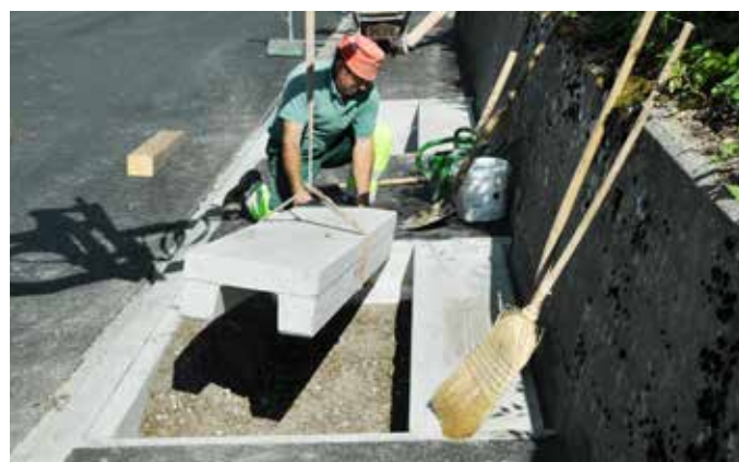
Versetzen der F+F Abdeckelemente
