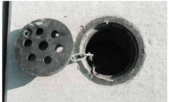
Belüftungs- und Bewässerungsstutzen
