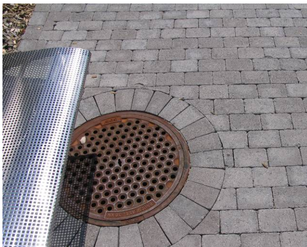
Bild 42: Anpassung bei Schachtabdeckung
