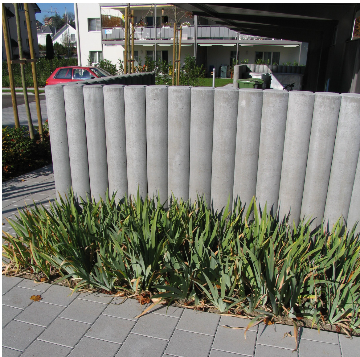
Bild 1: Betonhohlpalisade rund
