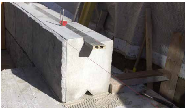
Bild 23 Streifenfundament mit Klebemörteldünnschicht
